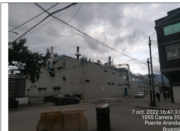
FOTOGRAFÍA No. 1. Fachada
